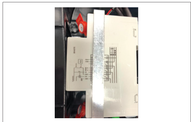
Abb. 45 Versiegelung des MID-Zählers
